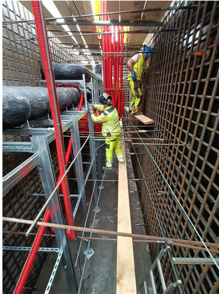
Alle rør og føringer bygges inn
